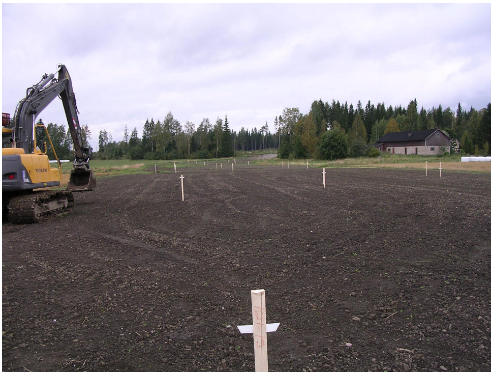
Kuva 12. Kuvassa on kaasuputkityömaalla hyvin tehty maisemointi ja työpaalutus.
