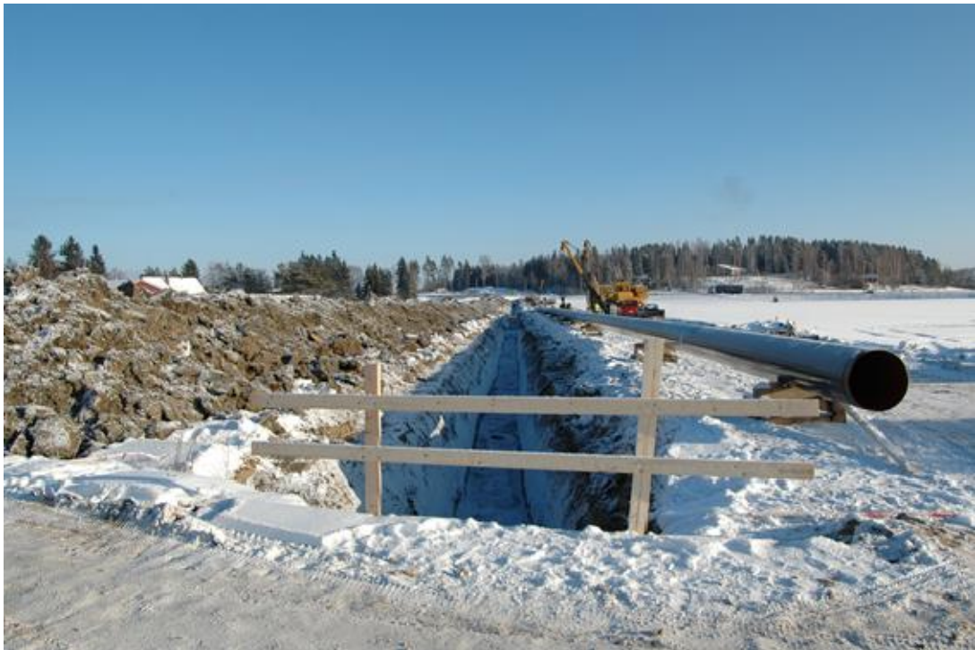
Kuva 1. Kuvassa näkyy maakaasuputki ja sille tehty kaivanto sekä kaivinkoneen käytössä oleva asennustie.
