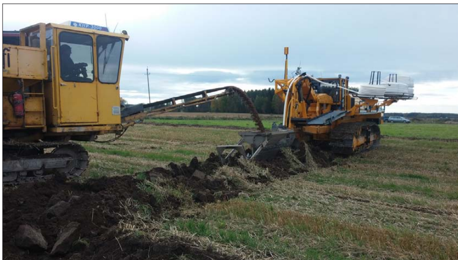
Dikesschakt som gjorts med grävande maskin (ovan) och plogande täckdikningsmaskin (nedre bilden).
