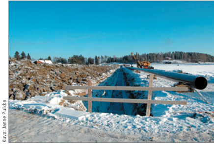
Kuva 4. Putkilinjotäyttö usein vetää peltojen poikki jolloin toimivia salaojia joudutaan katkaisemaan ja korjaamaan.
