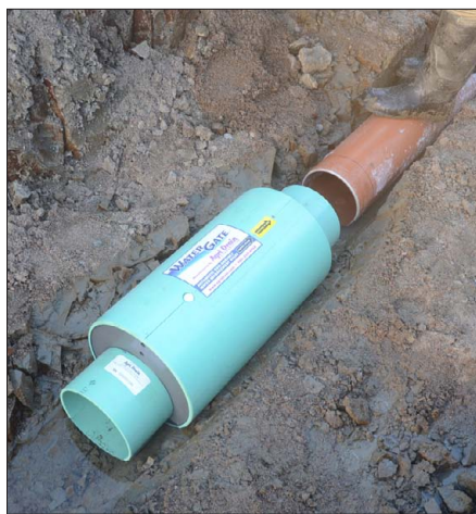
Kuva 3. Water Gate -venttiilin asennus Söderfjärdenillä. (Kuva: Rainer Rosendahl.)
