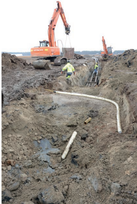
Bild 10. Täckdiket repareras med ett kompletterande dike när linjen korsar täckdiket i en mycket liten vinkel, så att linjen löper nästan parallellt med täckdiket på en över tre meter lång sträcka. Bild: Rainer Rosendahl
