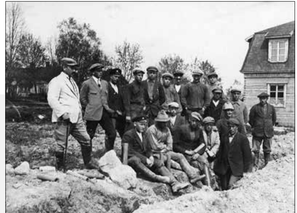
Salaojituskurssin vastaanottajia Vestankvarnissa vuonna 1923. Käytännön työskentelyä johti maatalousteknikko Ivar Steffansson (2. vasemmalta).
