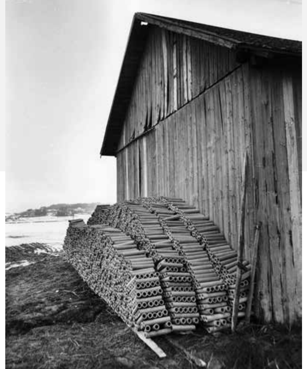
Hintasäännöstelyn ja liikevaihtoveron poistuminen vaikuttivat putkituotantoon piristävästi.
