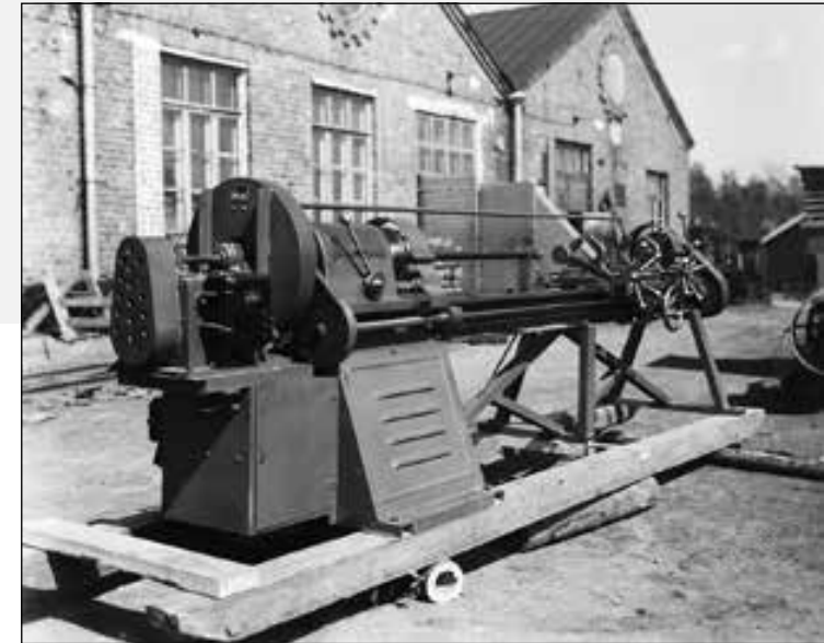
Jyväskyläläisen tehtaan ”salaputkikone”, jonka valmistamalla puuputkilla ei ollut toivotunlaista menekkiä.
