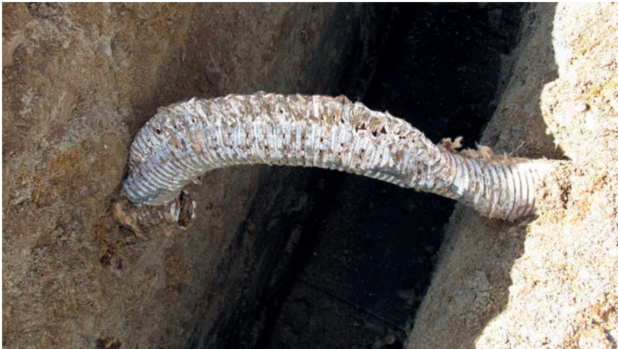
Kuva 6. Katkaistu salaojaputki. Kuva: Rainer Rosendahl
