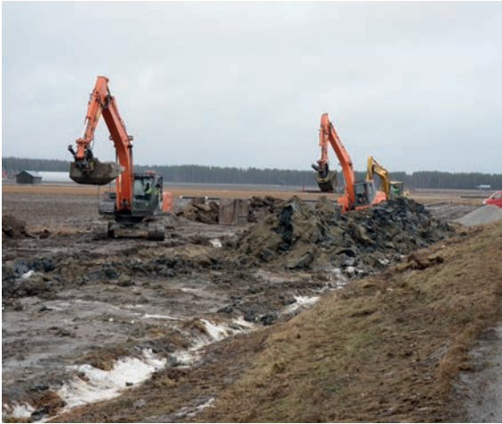
Kuva 12. Hyvä työtapa on käyttää erillistä korjaustyöryhmää, joka järjestelmällisesti korjaa rikkoutuneet kohdat, jotta varsinaisen linjan rakentajat voivat edetä työssään. Kuva: Rainer Rosendahl
