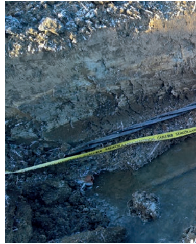
Kuva 13. Salaojan korjaus pitää tehdä heti tai viimeistään muutaman päivän sisällä, jotta avoimeen putkeen ei päädy maata tms. Kuva: Airi Kulmala
