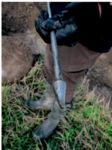
Halutut kohteet haetaan yleensä salaojakartan ja mittanauhan tai harpan avulla.
