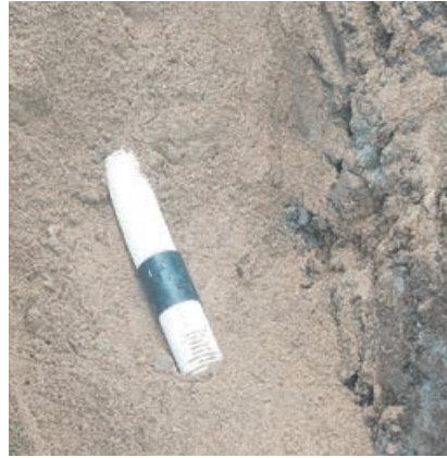
Liitosholkilla tehty putkiliitos. (alla)
