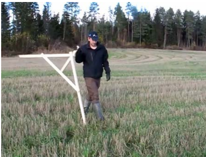
Halutut kohteet haetaan yleensä salaojakartan ja mittanauhan tai harpan avulla.
