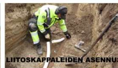
LIITOSKAPPALEIDEN ASENNUS
