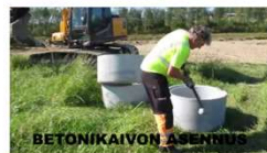
BETONIKAIVON ASENNUS
