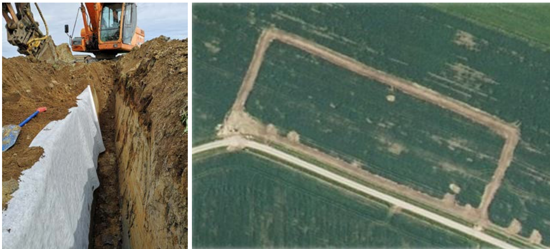
Kuva 2.9. Säätösalaajitettu koalue eristettiin muovikalvolla.
