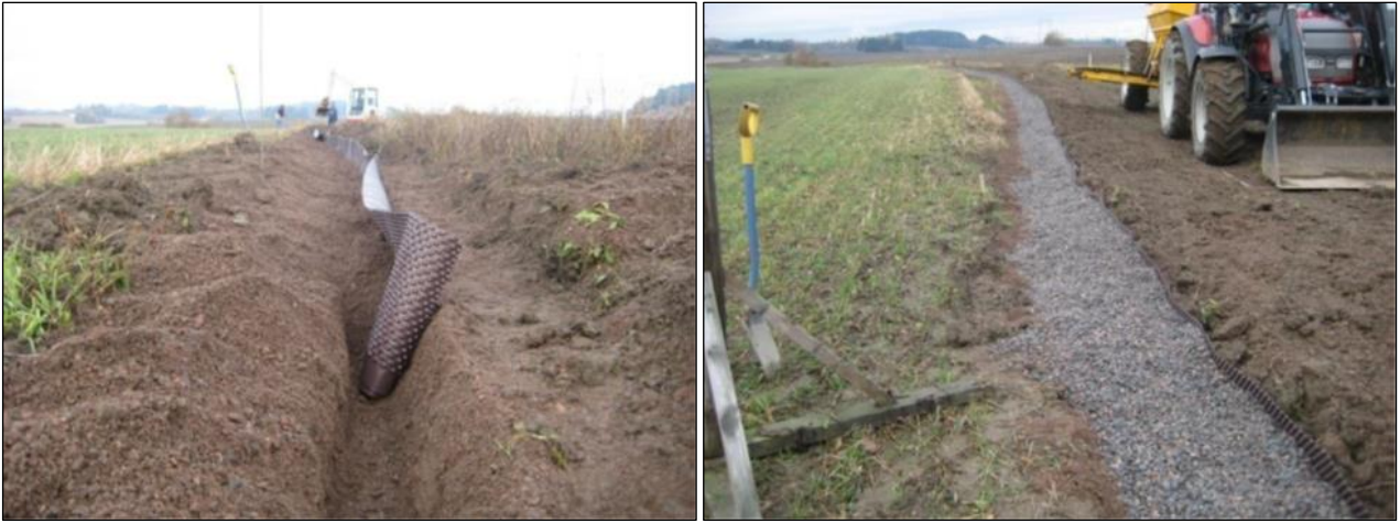
Kuva 2.5 Pintakerrosvalunnan keräämistä varten koelohkojen alaosaan tehtiin soralla täytetty kaivanto ja muoviseinä syyskuussa 2009, kuvassa alue 1.
