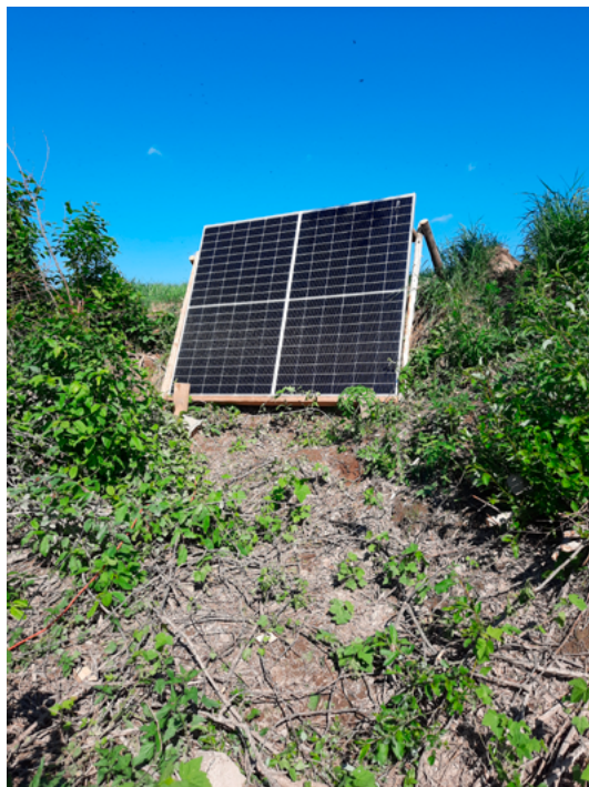
Kuva 7.2. a) Aurinkokennotoiminen pumppu ja b) virtalähteenä toimiva aurinkopaneeli. Pumppu on asennettu lautalle, koska joen vedenpinnan korkeuden vaihtelut ovat suuria ja laitetoimittajan suositus kyseiselle pumpulle on, että imuletku olisi mahdollisimman lyhyt. Aurinkokennotoimisen pumpun virranlähteenä toimiva aurinkopaneeli on asennettu joen penkalle. Aurinkoenergiaa on usein eniten saatavilla, kun kastelun tarve on suurin. (Kuvat: Minna Mäkelä.)
