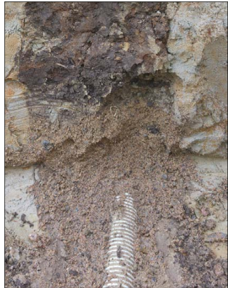
I Finland används oftast grus som kringfyllnadsmaterial kring täckdikesrören.
