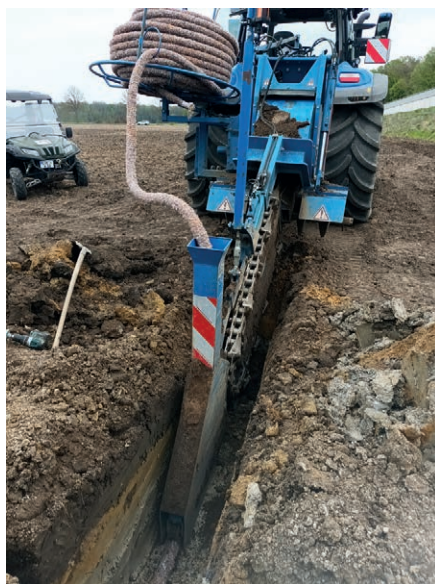
Kuva 4. Kuva LIBA:n työmaalta, jossa peltolohko osittain uusintaojitettiin traktoriin kiinnitettävällä kaivavalla salaojakoneella. Kohteella käytettiin esipäällystettyä putkea, eikä salaojasoraa käytetty lainkaan. (kuva: Olle Häggblom)
