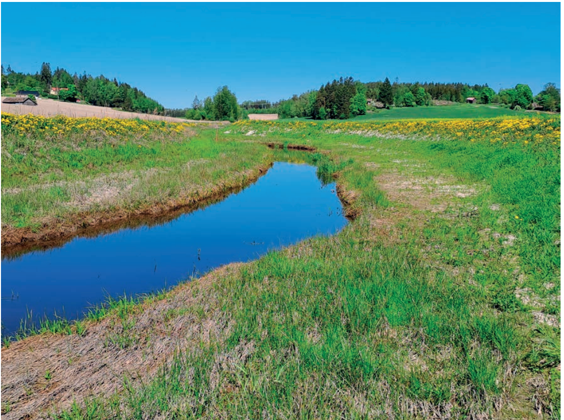
Kuva 8. Peruskuivatuksen tavoitteena on järjestää vedelle poistumisreitit kohti suurempaa vesistöä. Kuvassa esimerkki kaksitasouomasta, joka on todettu toimivaksi muussa eroosion vähentämisessä ja ekosysteemipalveluiden lisäämisessä. Kuva: Kaisa Västilä.
