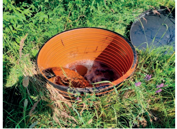
Kuva 34. Salaojakastelu toteutetaan käytännössä syöttämällä salaojaputkistoon vettä joko säätökäivon tai erillisen kastelua varten rakennetun jakokäivon kautta. Kuva: Antti Haho.
