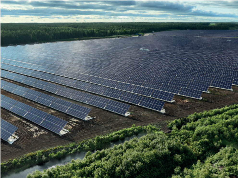
Kuva 29. Lapualla sijaitseva Heininnevan aurinkopuisto on rakennettu entiselle turvetuotantoalueelle. Säätösalojitus on välttämätöntä alueen sulfaattipitoisen pohjamaan vuoksi. Se mahdollistaa lisäksi alueen pitämisen märkänä, vaikka tilapäinen kuivatus esimerkiksi huoltotöitä varten on mahdollista. Kuva: EPV Aurinkovoima Oy.
